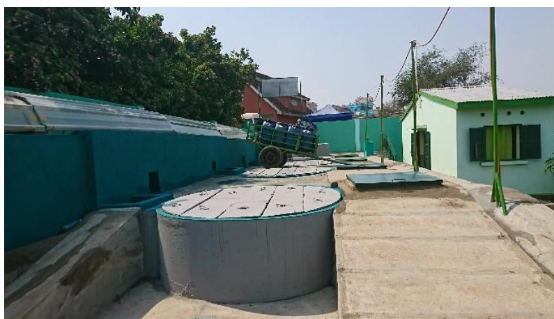
Figure 1 : un des sites de traitement de boue de vidange.
